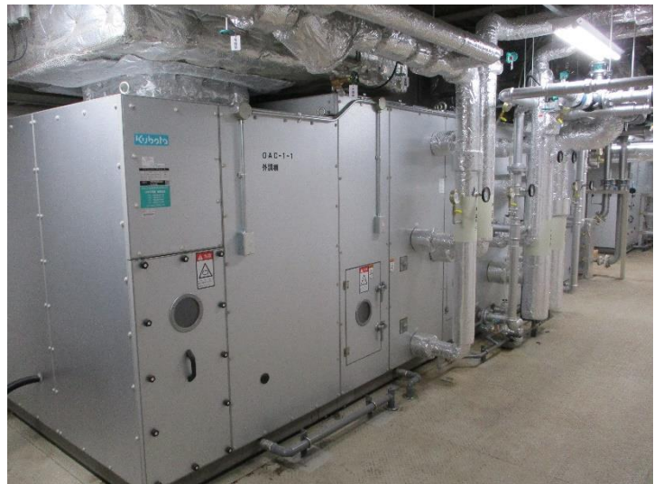
排熱利用余熱コイル搭載 外気処理空調機
