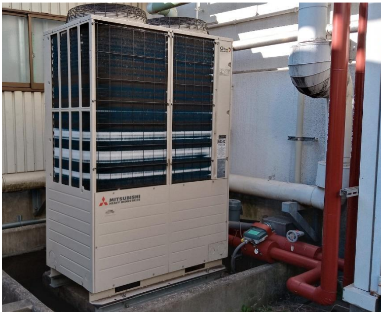
空気熱源ヒートポンプ (Q-ton_Circulation)
