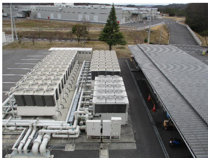
冷専チラーとヒートポンプチラー
