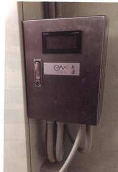
「ル・トロワ」の屋上と5階の室外機64台を2台の「エコミラ」（左）で制御する
