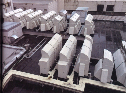
「ル・トロワ」の屋上と5階の室外機64台を2台の「エコミラ」（左）で制御する
